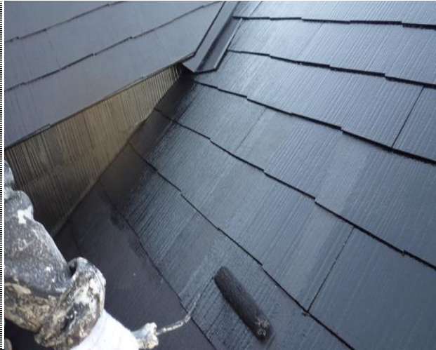
屋根塗装 上塗り
