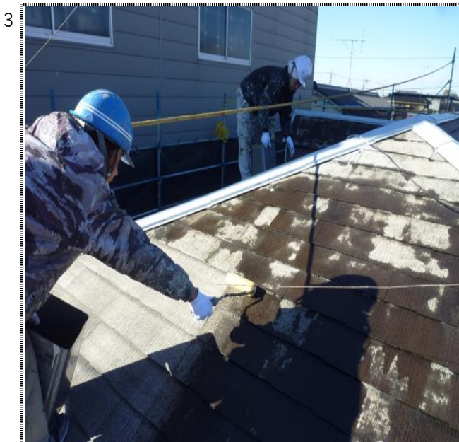
屋根塗装 下塗り
