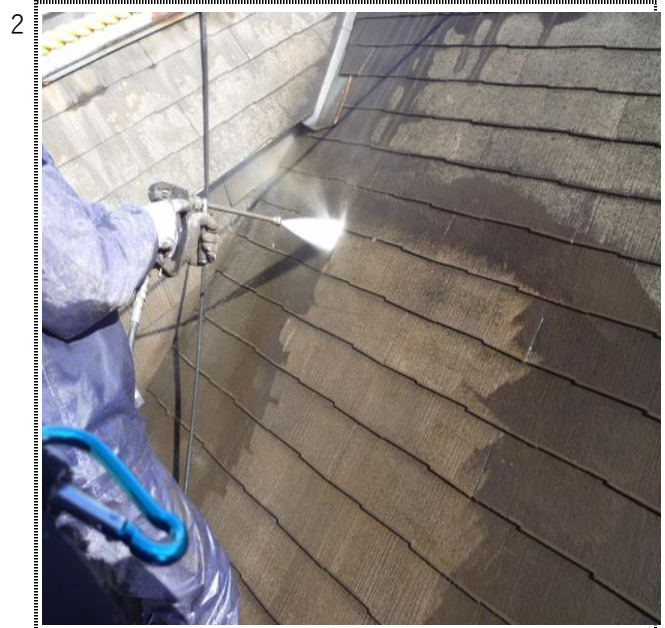
屋根 高圧洗浄
