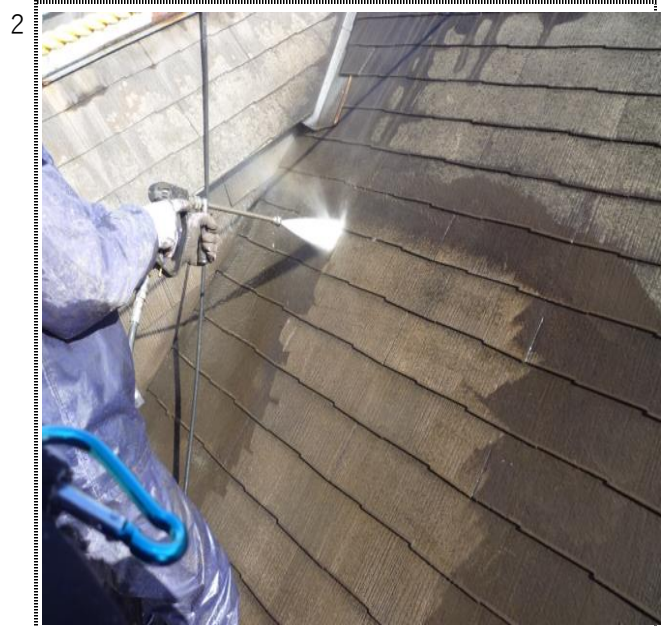
屋根 高圧洗浄
