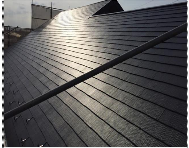
屋根 塗装工事 完了
